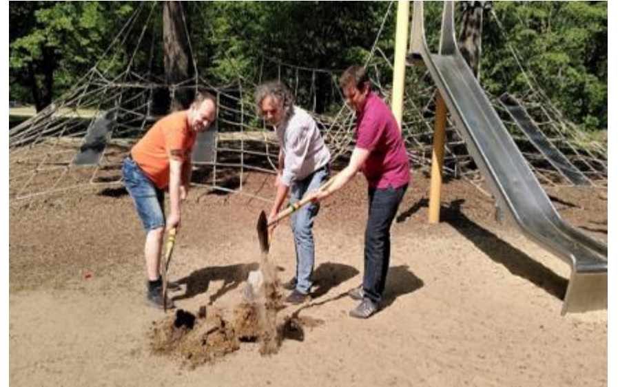
Spatenstich → Jungfernheide Spielplatz am 22.05.23
