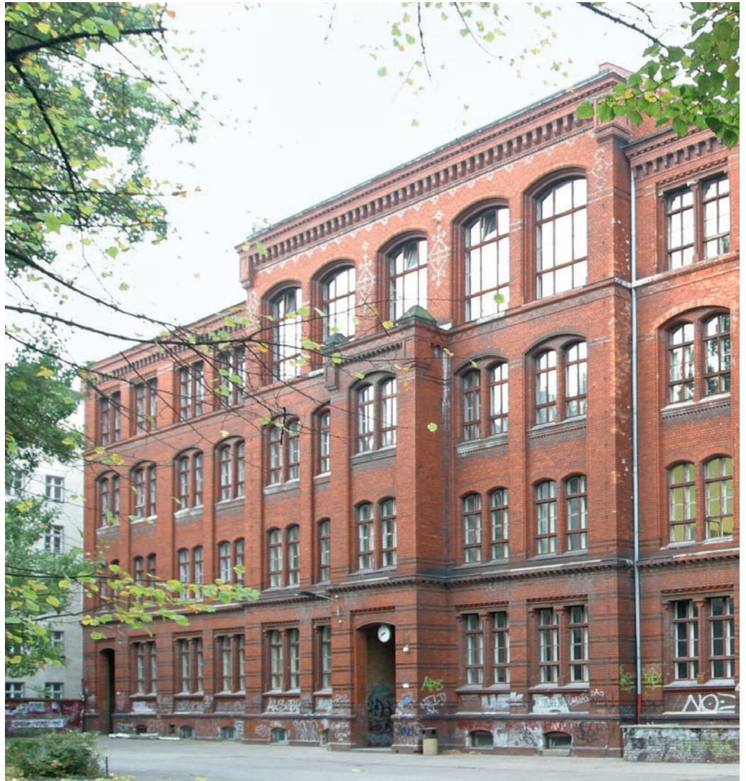
Danziger Straße 50, vor dem Umbau Blick aus dem Treppenhaus Grundsaniierung der Klassenräume Schulhof vor der Sanierung
