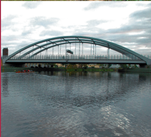
Brücke über den Britzer Zweigkanal
