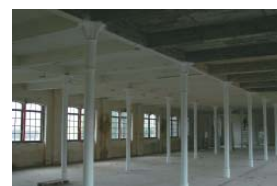
oben: die Velvetfabrik während der Sanierung ganz oben: neu eingerichtete Verkaufsetage; unten: Blick während der Sanierung
