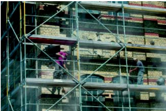
Sanierung der ehemaligen Velvet- Fabrik in der Köpenicker Straße 20
