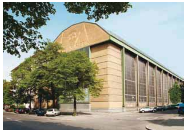
Die Montagehalle für Turbinen von Peter Behrens
