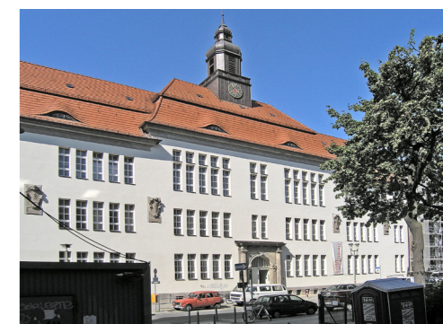
Erneuerte Fassade der Schule am Koppenplatz © KoSP GmbH
