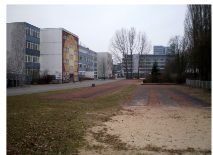
Die Sportanlagen vor der Erneuerung
