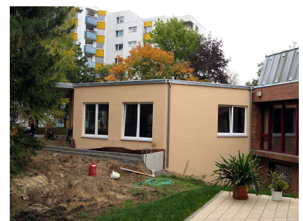
Der Kita-Anbau kurz vor der Fertigstellung
