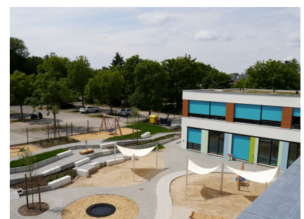
Blick vom Gründach auf die Freifläche
