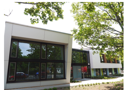
Die Kita verfügt über eine Bewegungshalle über zwei Geschosse
